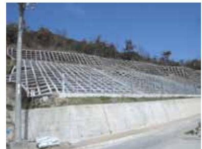
▲治山工事後の現場
