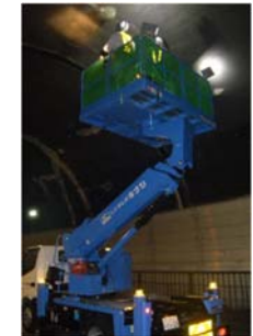
トンネル点検
