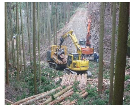
木材積込・搬出状況
