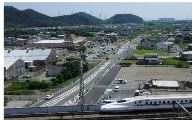
大日線整備状況(新幹線南側を望む)
