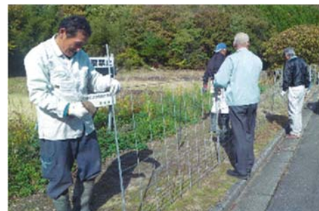
住民参加による獣害防止柵の設置
