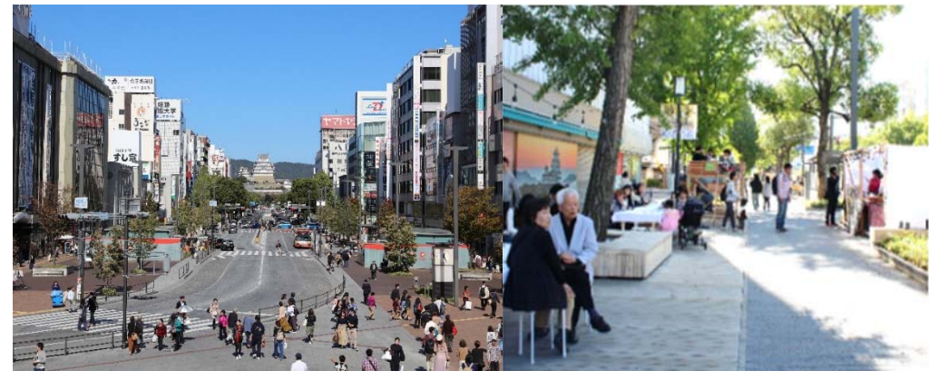
再整備工事後の大手前通り
