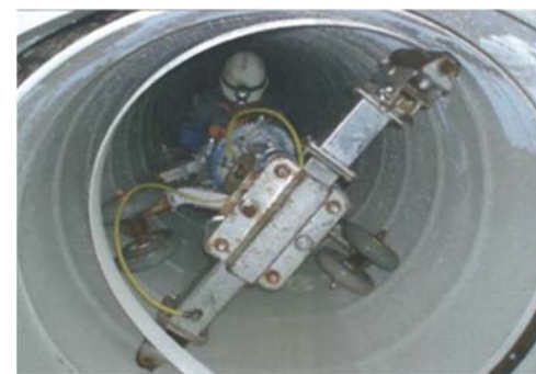
老朽管更生工事の作業状況
