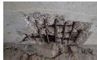
損傷状況(剥落、鉄筋露出)
