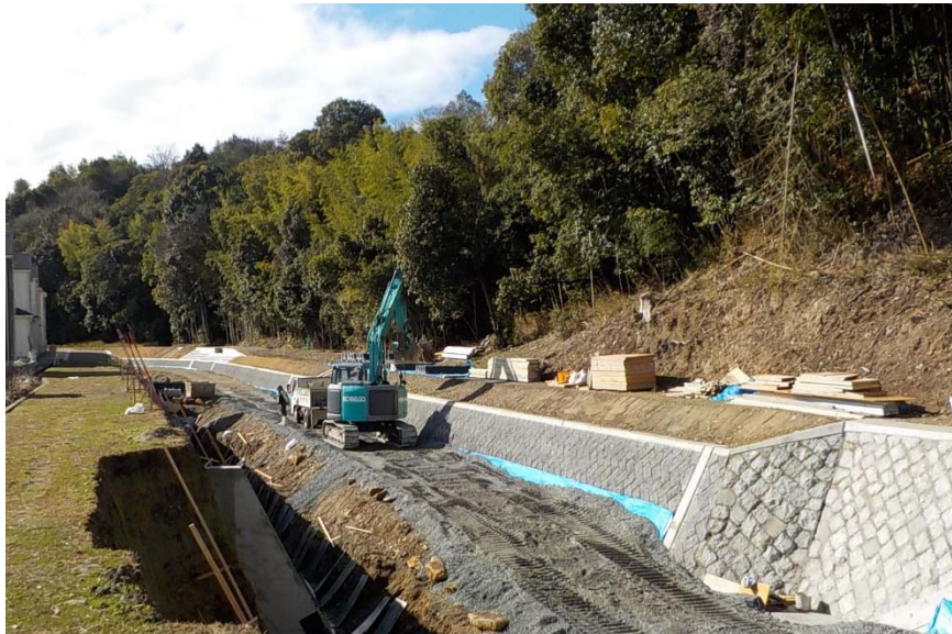
河川護岸工事の様子
