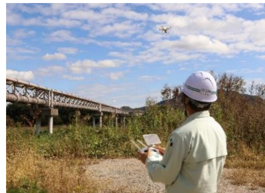
ドローンを使用した 水管橋の緊急空撮点検
