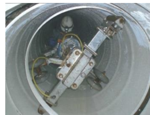
老朽化した下水道管きよの更生
