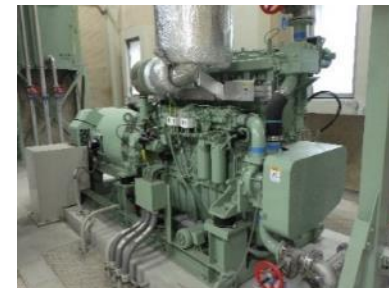
非常用自家発電設備の設置例
