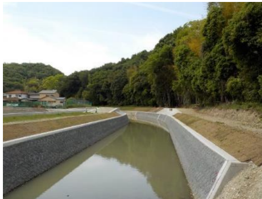
大井川工事整備状況
