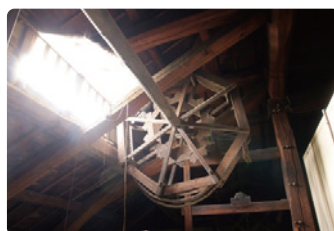
蔵の2階にある木枠の滑車「八重巻」。酒を搾る時に使う、重たい石を吊り上げるための道具
