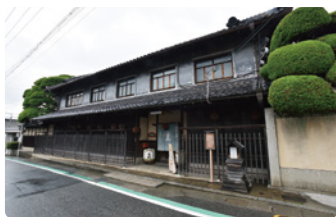
湯の山街道に面した風情ある建物は三木のランドマークのひとつ
