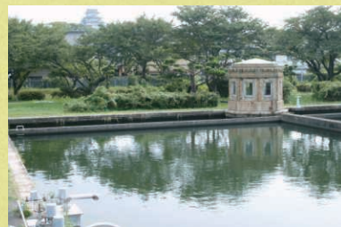
①町裏浄水場(姫路市) 姫路市で上水道が給水されたのは1929年のことです。町裏浄水場は当時の姿がほぼ完全な形で残っている近代水道施設です。
