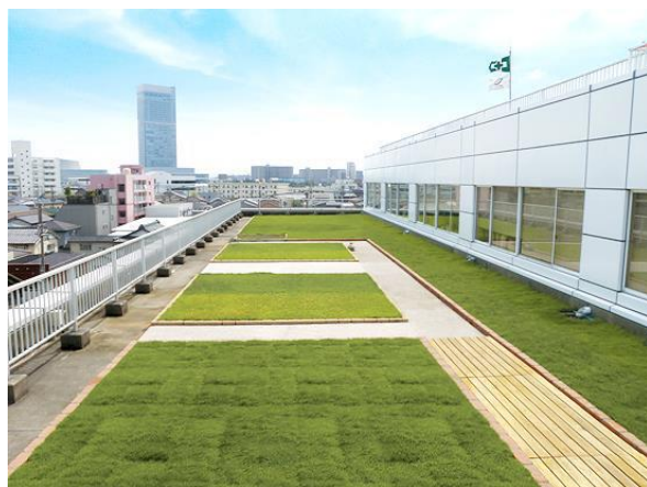
＜屋上緑化の例＞
