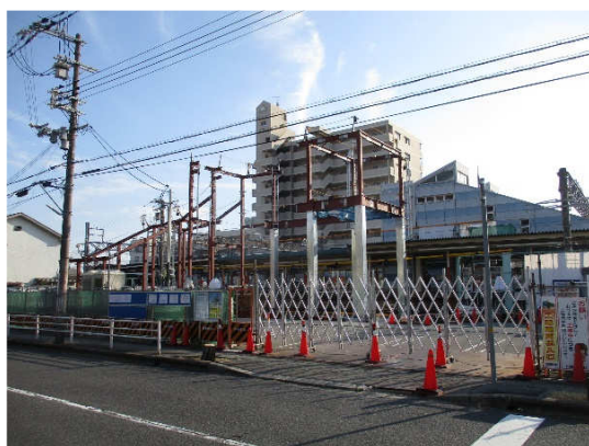
参考：山陽電鉄飾磨駅のバリアフリー化の状況
