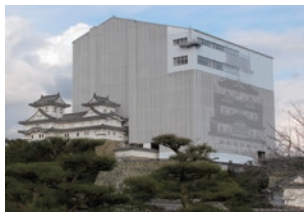
◀平成の大修理の様子
