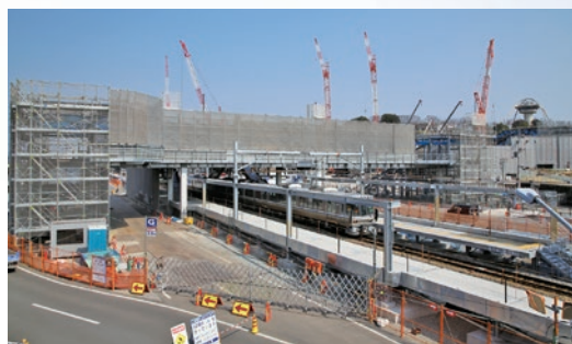
建設中の新駅（3月撮影）
