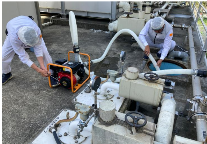
タンクと給水車を接続する様子
