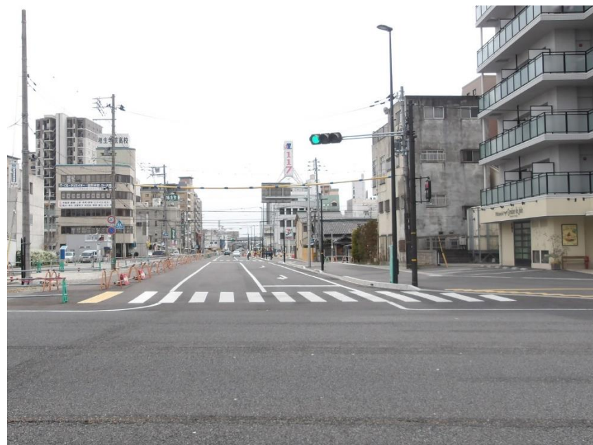
内環状東線(北工区) (北から南)整備中
