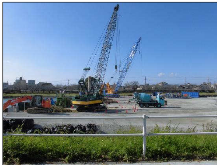
鹿谷田線起点（東から西）事業中
