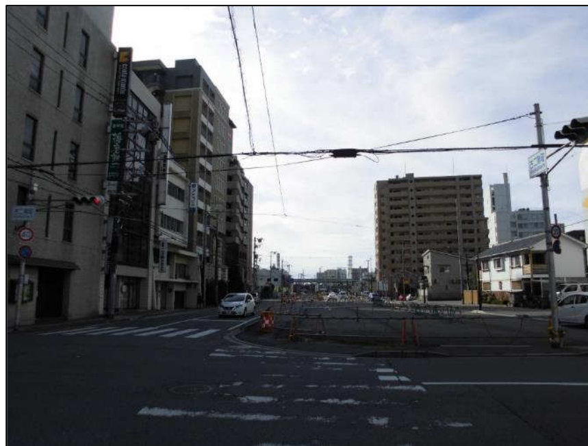
内環状東線 (北から南)整備中
