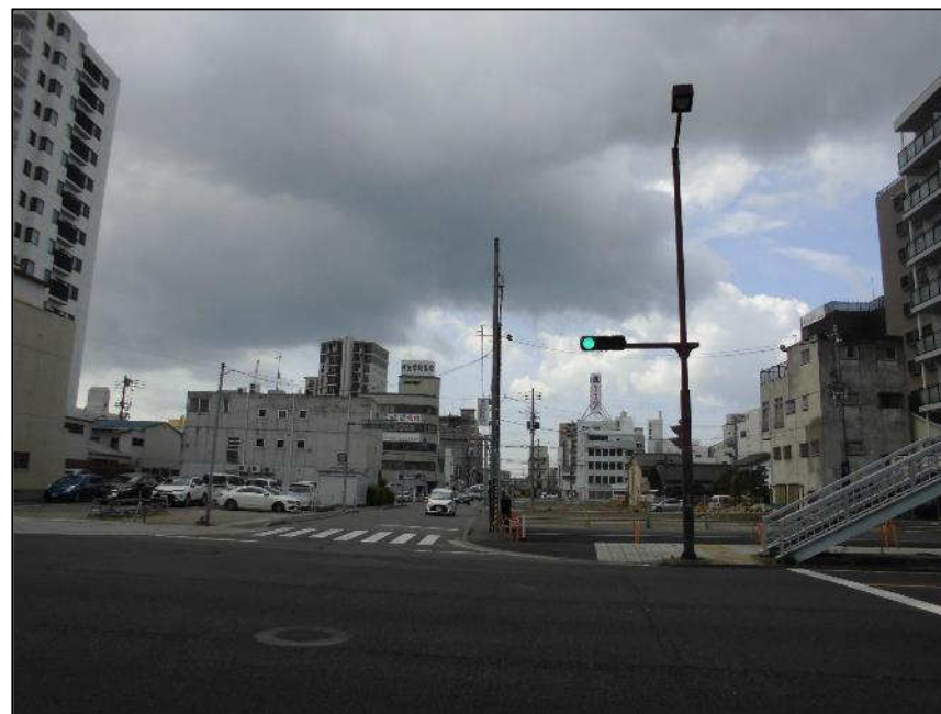
内環状東線(北工区) (北から南)整備中
