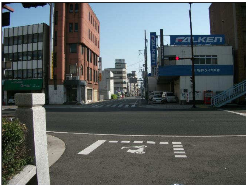
内環状東線(北工区) (北から南)整備前
