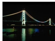
明石海峡大橋
