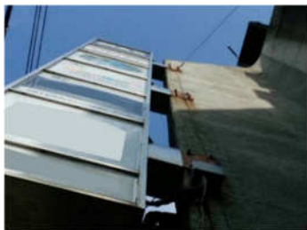
壁面に取付部の汚ダレが見られ所定の場所にアンカーボルトが埋め込まれていない状態
