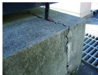
根巻きと支柱との隙間があり、基礎にクラックが入った状態 さびが進行した状態
