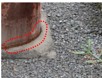
根巻きと支柱との隙間があり、基礎にクラックが入った状態 さびが進行した状態
