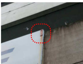
取付部の腐食が進行、汚ダレが金具が劣化した状態 見られる状態
