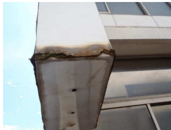
側板底面が腐食、破損、変形した状態
