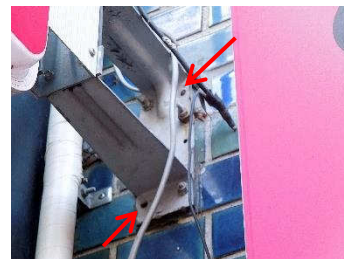
壁面に取付部の汚ダレが見られ所定の場所にアンカーボルトが埋め込まれていない状態
