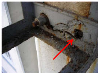
壁面に取付部の汚ダレが見られ所定の場所にアンカーボルトが埋め込まれていない状態
