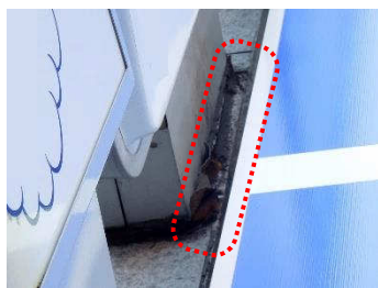
アンカーボルトのさびが進行し、ネジ山が欠損した状態
