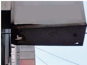
側板底面が腐食、破損、変形した状態
