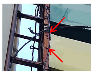
ボルトのゆるみや欠落した状態
