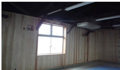
農業振興センターの研修棟
