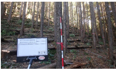
間伐材を土留材として利用
