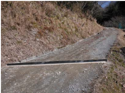
資材支援による林道の路面排水処理
