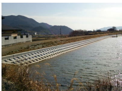
改修されたため池（山田町牧野）
