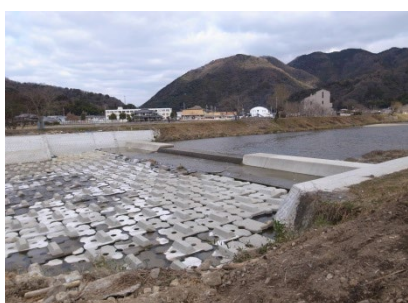
夢前川の井堰改修（夢前町）
