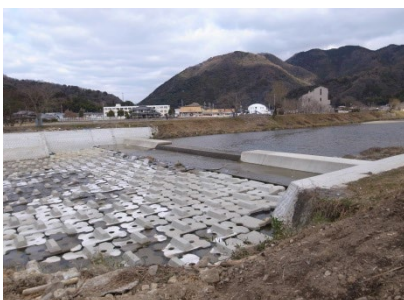
夢前川の井堰改修（夢前町）
