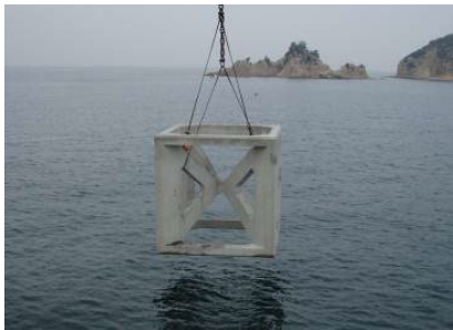
魚礁の設置（家島町）
