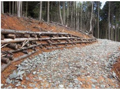
作業道における丸太組工
