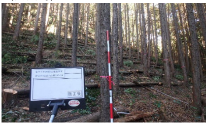
間伐材を土留材として利用
