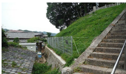
山腹崩壊対策（夢前町前之庄）
