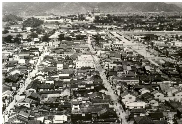
大手前通りの工事（高橋秀吉コレクション）
