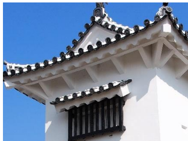
壁・軒裏の漆喰塗り
