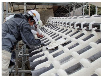
保存修理中の屋根
