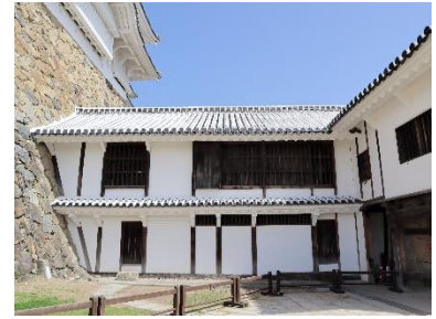
折廻り櫓（真壁造り）
