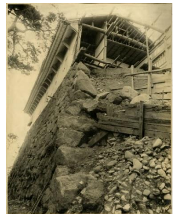
西の丸石垣の崩落
