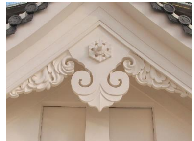
破風・懸魚の漆喰塗り
