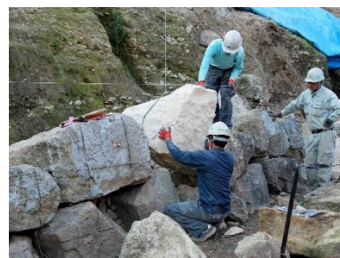
石垣の保存修理
