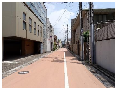
⑪中堀跡舗装
