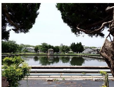
⑭町裏浄水場
