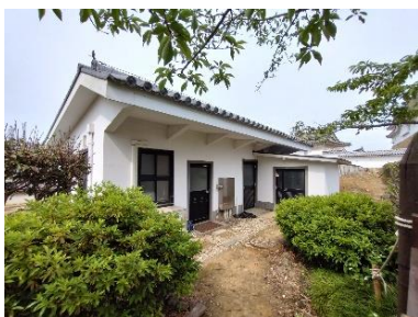
㉕ポンプ室
