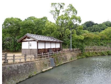
⑭西部中堀ポンプ施設
