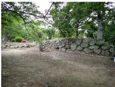
⑦御本城土蔵基礎石垣
