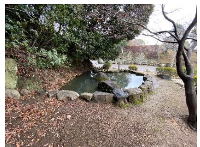
⑫堀水循環用ポンプ施設
