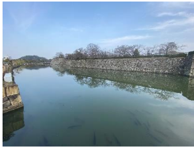
④ 南部内堀（桜門橋以西）
