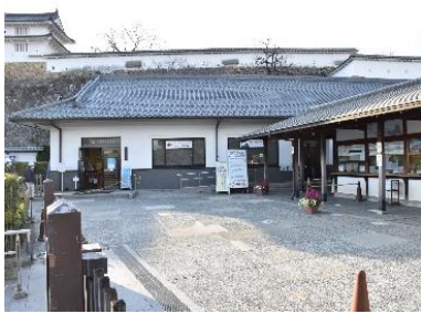
㉒姫路城防災センター
