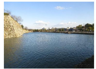
⑥ 南部内堀（最大幅部分）
