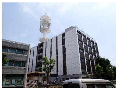
⑭NTT 施設（建造物・アンテナ）
