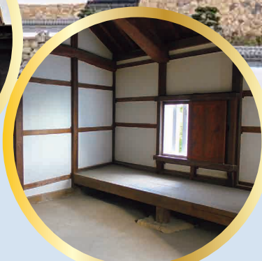
姫路城 トの櫓内部
