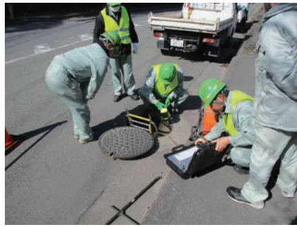
下水道管のカメラ調査の様子
