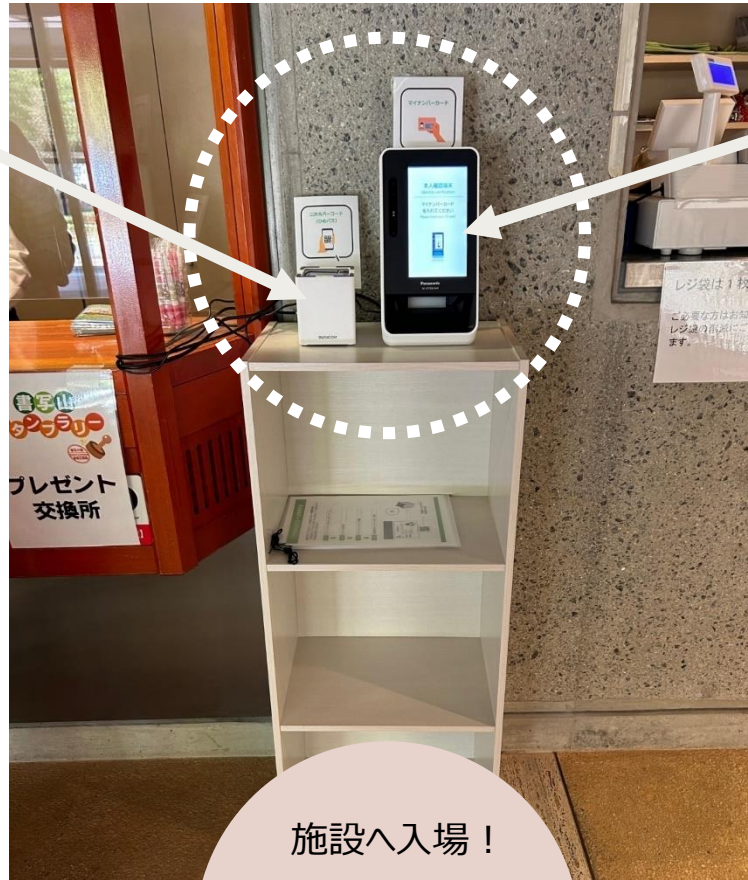
機器設置例（書写の里・美術工芸館）
