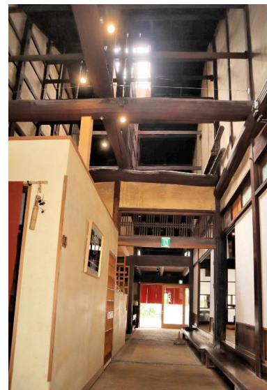
内部 南側土間
