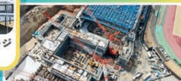
アリーナ姫路 建設中の様子 建物の内部にも鉄が活躍！
