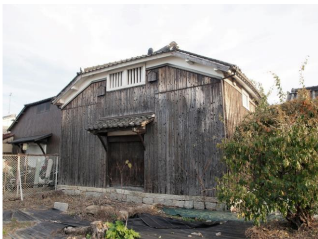
材木倉庫 外観 北面
