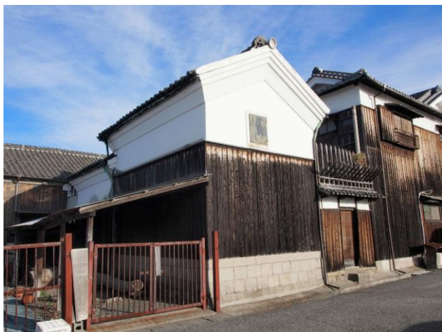
土蔵 外観 北西より
