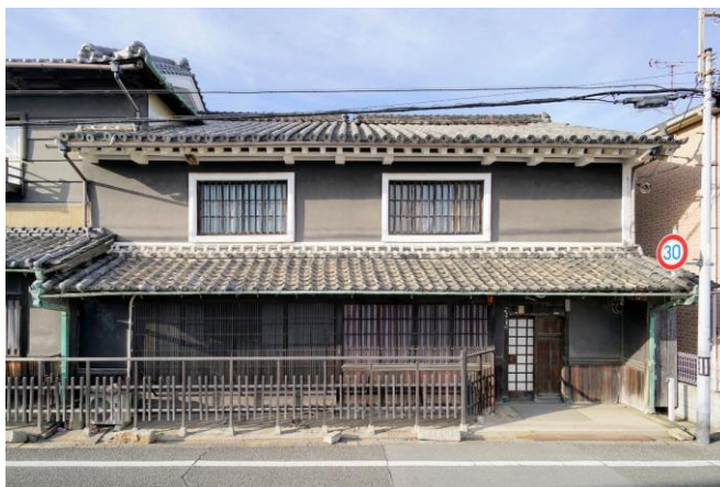
主屋 外観 正面(南面)
