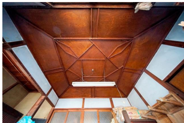
店舗兼住居 内部1階 ミセの天井
