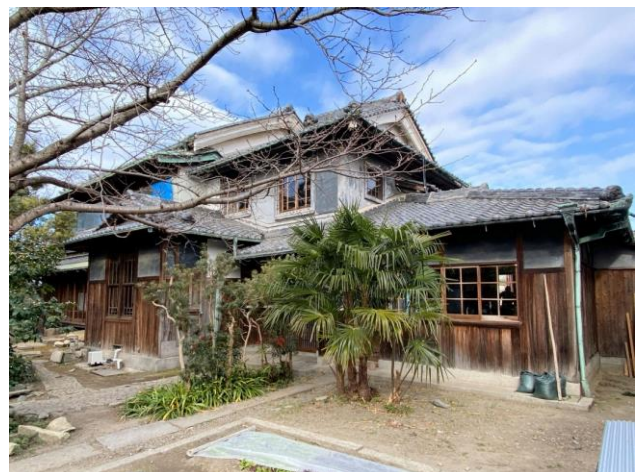
主屋 外観正面(南面) 東半部分
