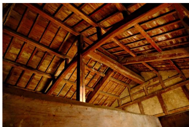
道具蔵 内部2階 小屋組み
