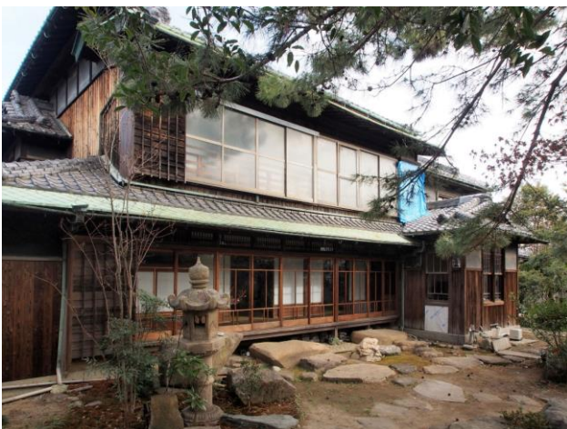
主屋 外観正面(南面) 西半部分
