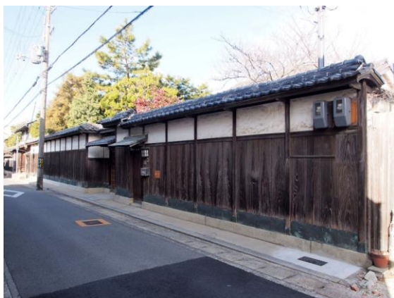
門及び塀 外観正面 南東より
