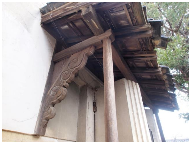
土蔵 正面戸口の持送り彫刻と吹寄せ垂木
