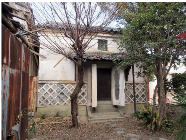
土蔵 外観正面（南面）
