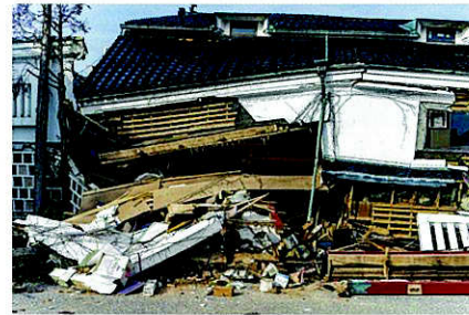
地震による被害例 (能登半島地震)
